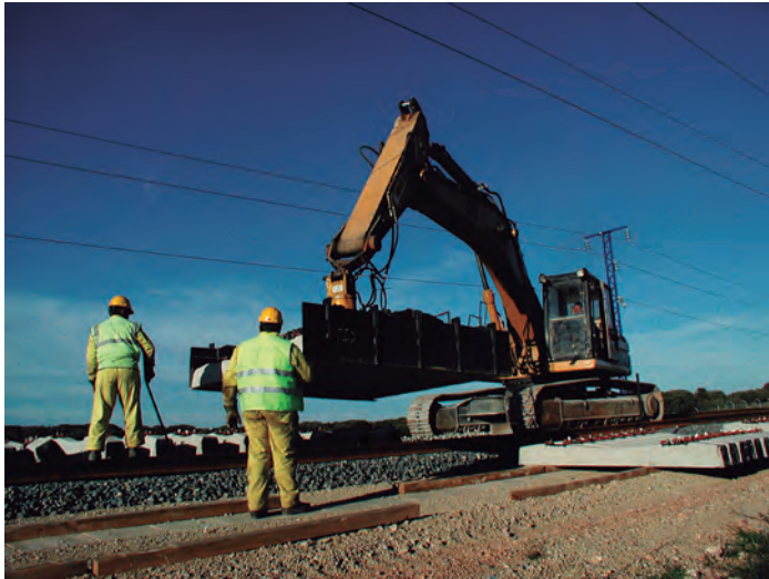
Imagen 2.11. Montaje de traviesas. Fuente: VIAS
