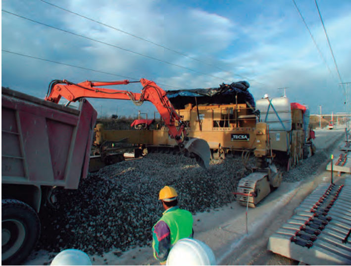
Imagen 2.3. Extendedora de balasto. Fuente: TECSA
