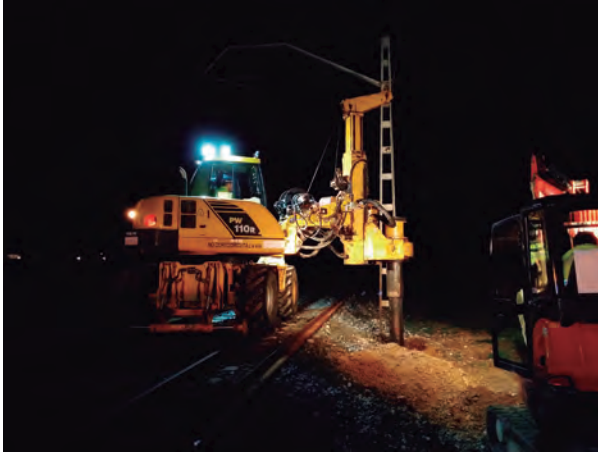
Imagen 2.30. Colocación de poste de catenaria. Fuente: TELICE
