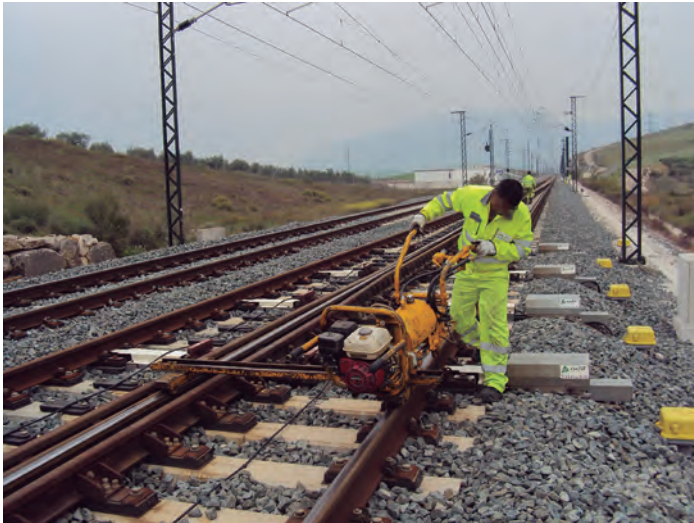
Imagen 2.20. Motoclavadora de carril. Fuente: TECSA
