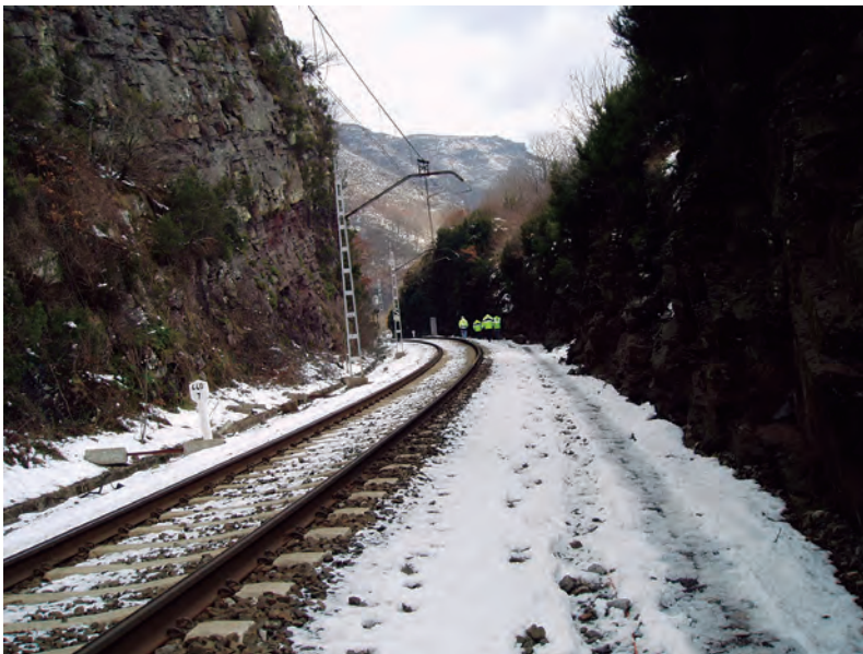
Imagen 3.19. Desplazamiento por la vía con nieve. Fuente: TECSA
