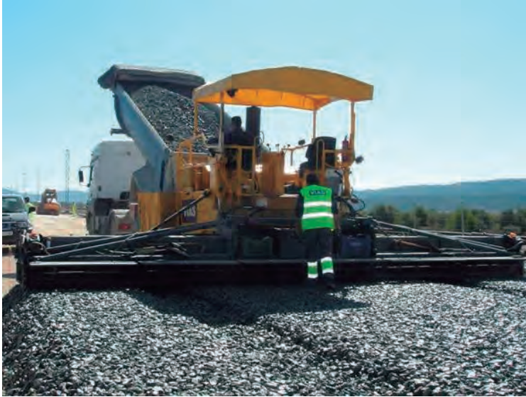
Imagen 2.2. Aporte de balasto sobre extendedora. Fuente: TECSA
