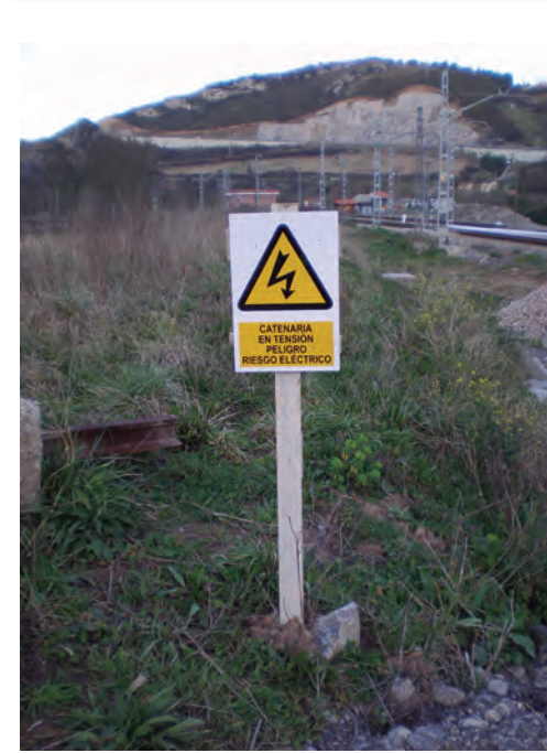
Imagen 4.4. Señalización riesgo eléctrico. Fuente TECSA
