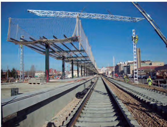
Imagen 2.31. Montaje pórtico de catenaria. Fuente: COMSA
