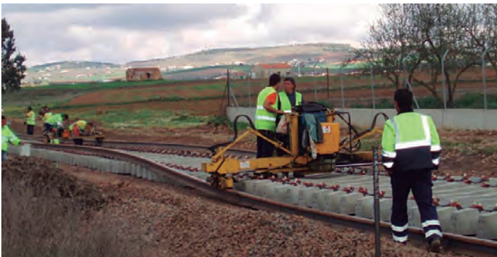
Imagen 2.19. Posicionadora de carril. Fuente: VIAS
