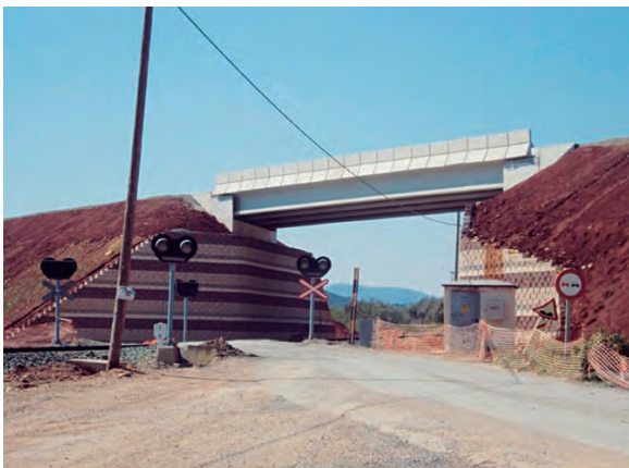
Imagen 5.11. Interferencia de los trabajos de ejecución de un paso a nivel con vía férrea en servicio. Fuente: VIAS
