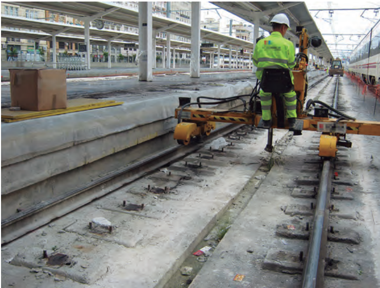
Imagen 2.29. Vía en Placa. Fuente: FLC
