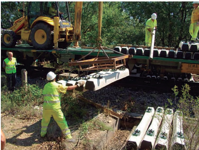
Imagen 3.10. Elementos de elevación. Fuente: COMSA
