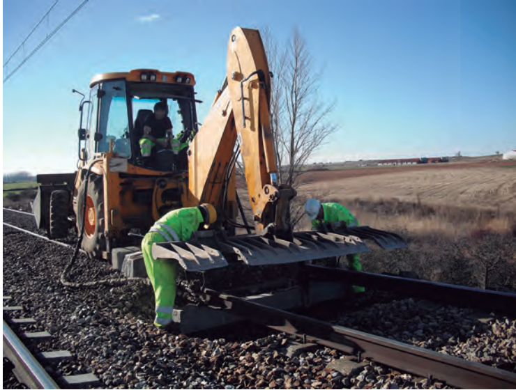
Imagen 2.12. Sustitución de traviesas con retroexcavadora bivial. Fuente: COMSA
