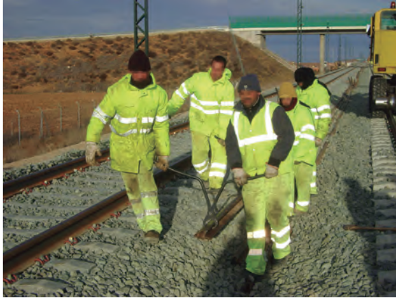
Imagen 2.18. Manipulación manual de tramo de carril. Fuente: COMSA
