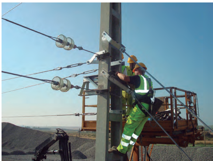
Imagen 6.11. Trabajos en catenaria. Fuente: COMSA
