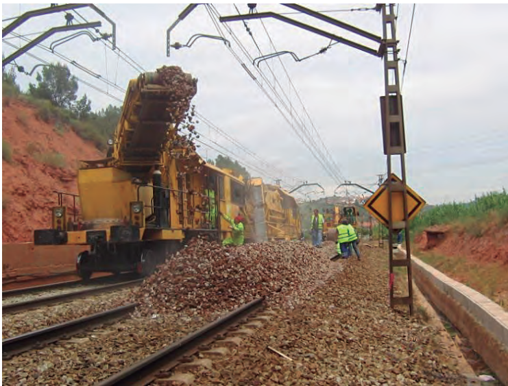
Imagen 3.7. Desalojo de material con desgarnecedora. Fuente: COMSA
