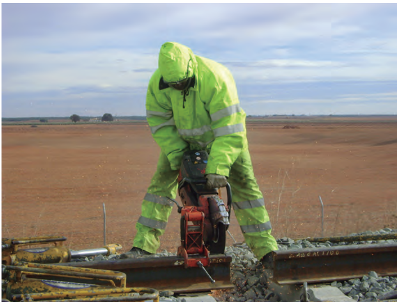
Imagen 3.8. Corte con tronadora. Fuente: COMSA
