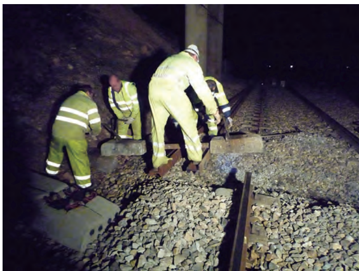
Imagen 2.37. Operarios trabajando en turo de noche. Fuente: FLC
