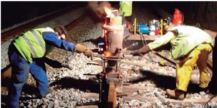
Imagen 3.9. Soldadura aluminotérmica. Fuente: COMSA
