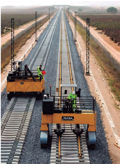
Imagen 2.14. Pórtico de descarga de carril. Fuente: TECSA
