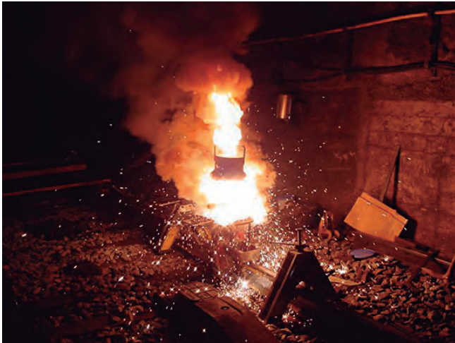
Imagen 3.22. Soldadura aluminotérmica. Fuente: COMSA
