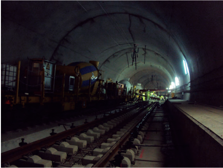
Imagen 2.35. Trabajos en interior de túnel. Fuente: TECSA
