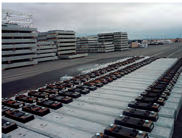
Imagen 2.8. Acopio de traviesas. Fuente: COMSA
