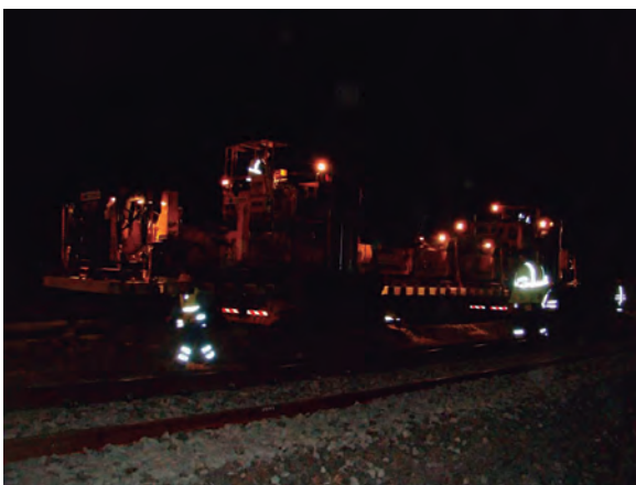
Imagen 5.8. Movimiento de avance de vehículo ferroviario en trabajo nocturno. Fuente: COMSA
