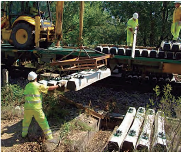
Imagen 2.10. Descarga de traviesas. Fuente: VIAS
