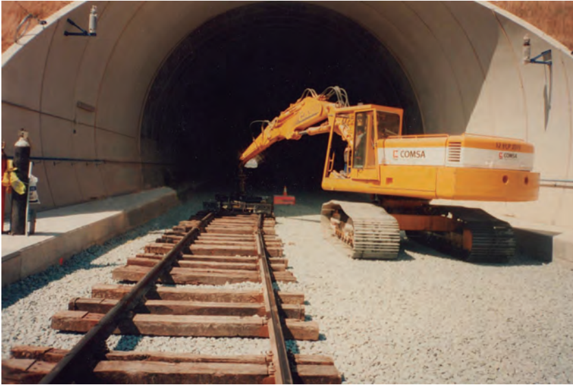
Imagen 2.33. Montaje de vía auxiliar en entrada a túnel. Fuente: COMSA
