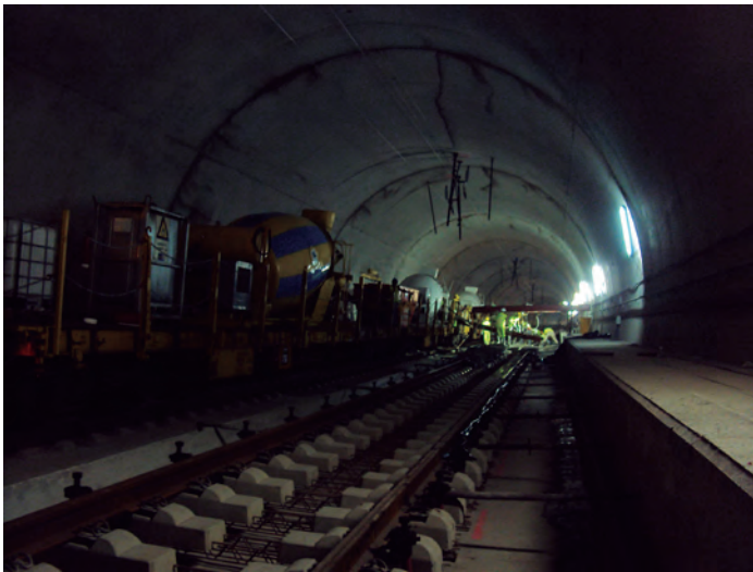
Imagen 2.36. Trabajos nocturnos. Fuente: TECSA
