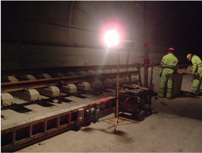
Imagen 3.28. Iluminación artificial en trabajos en túnel. Fuente: COMSA
