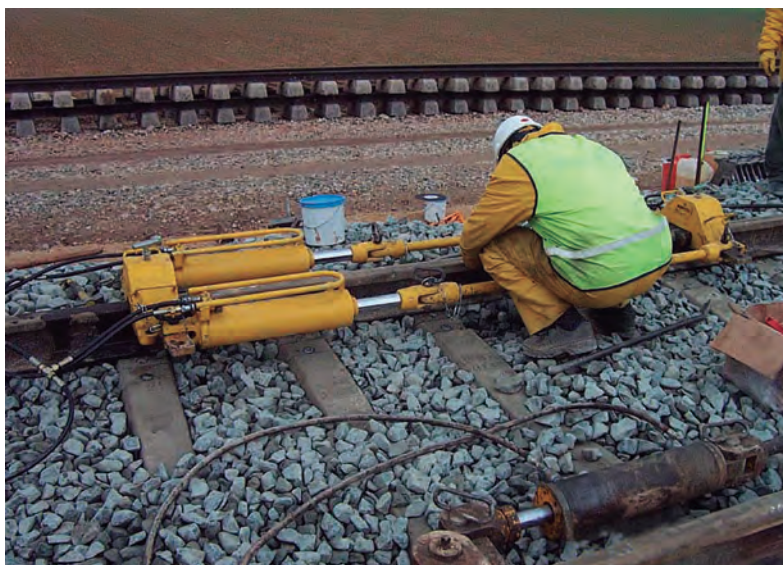
Imagen 2.18. Liberación Tensiones. Fuente: VIAS
