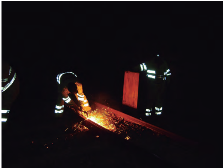
Imagen 3.23. Soldadura oxiacetilénica. Fuente: TECSA
