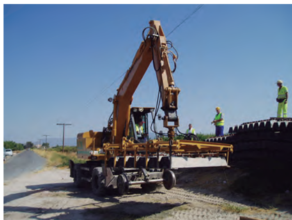
Imagen 2.1. Descarga de materiales. Fuente: VIAS
