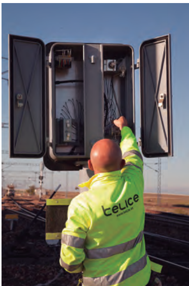
Imagen 2.32. Revisión instalaciones de seguridad. Fuente: TELICE
