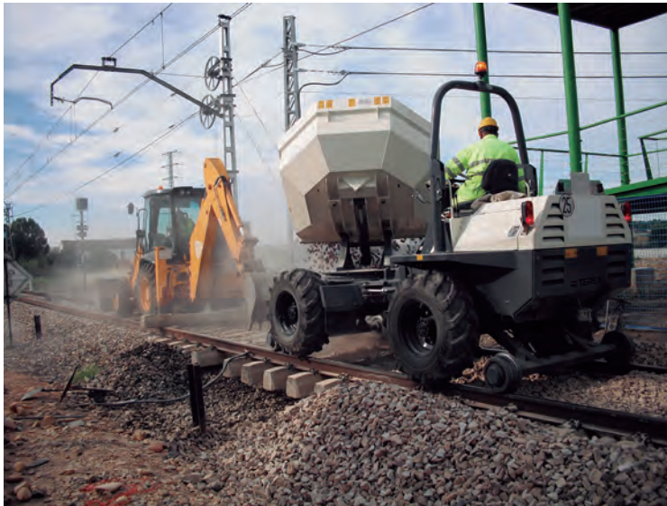
Imagen 2.7. Dumper sobre diplorys. Fuente: TECSA
