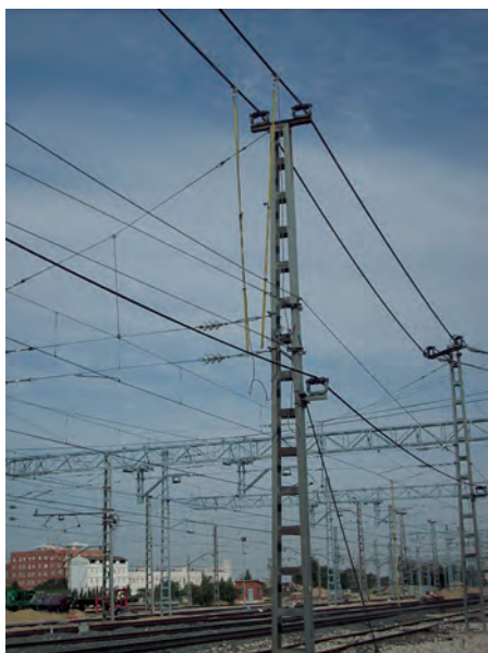
Imagen 6.9. Pértigas de puesta a tierra. Fuente: VIAS
