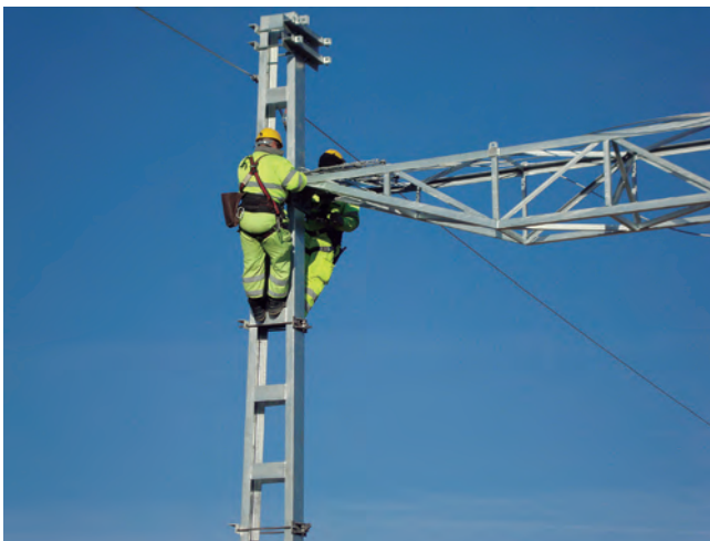
Imagen 3.17. Trabajos con riesgo eléctrico. Fuente: COMSA
