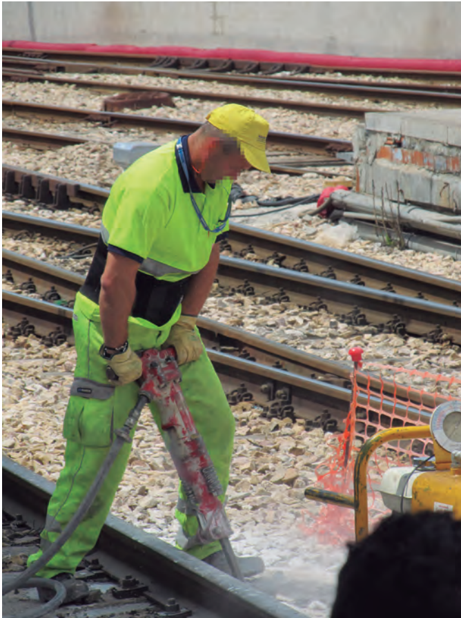
Imagen 3.25. Trabajo con martillo neumático. Fuente: FLC
