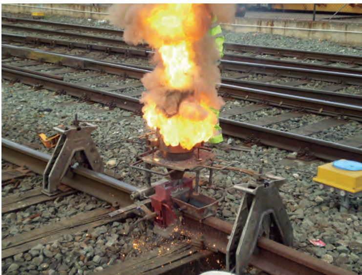
Imagen 2.26. Soldadura Aluminotérmica. Fuente: TECSA
