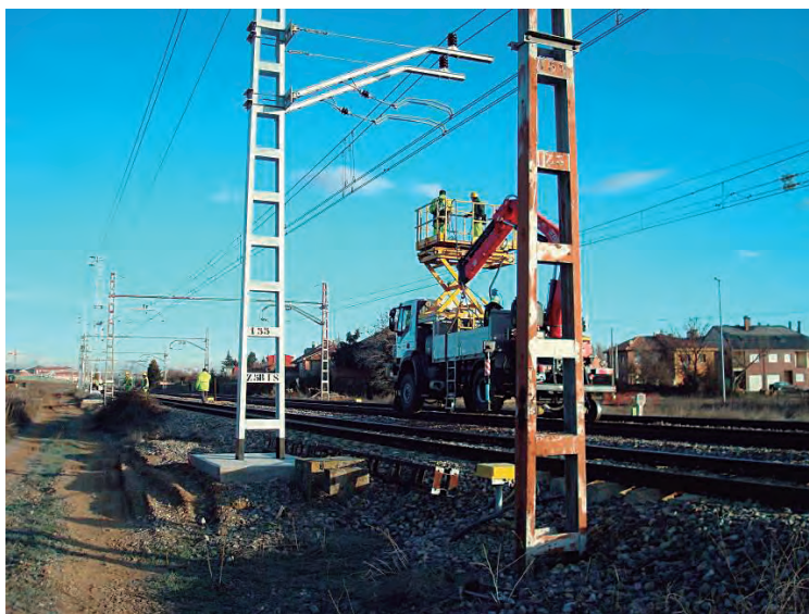
Imagen 6.5. Vehículo con plataforma elevadora en vía. Fuente: COMSA
