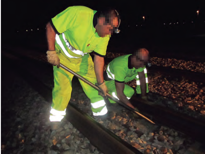
Imagen 3.18. Trabajos con riesgo de sobreesfuerzo. Fuente: FLC
